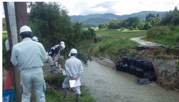
恵那市内 蔵前橋 橋梁災 現地調査の様子
